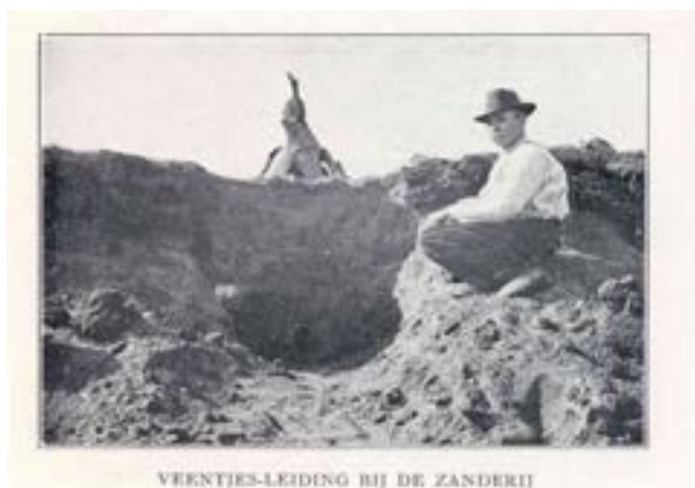
Afbeelding 6.3 Foto uit "Een vergeten waterwerk", hier zit Kremer in de "Zanderij" nabij Assel waar het leidingstracé uit de wand van de zandgroeve is zichtbaar gemaakt, we zien zelfs nog een aardewerk buis uitsteken! Foto door zijn vriend C.F. Kruisinga. Vermoedelijk in de zomer van 1932.
