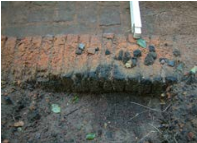
Afbeelding 4.4 Korte zijde van de oven van half gebakken stenen (bron: foto Maarten Wispelwey).
