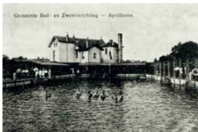
Afbeelding 11.7 Gemeentelijke Bad- en Zweminrichting. Op de voorgrond het zwembegedeelte en op de achtergrond de achtergevel van het badhuis daterend uit 1921 (bron: CODA beeldbank).
